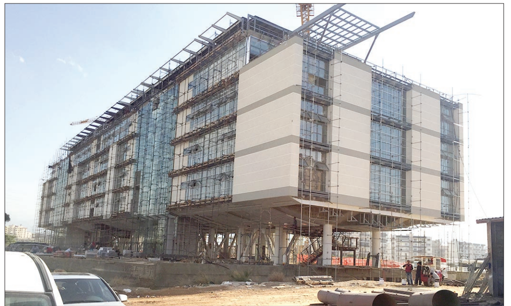
المبنى الجامعي حالياً
